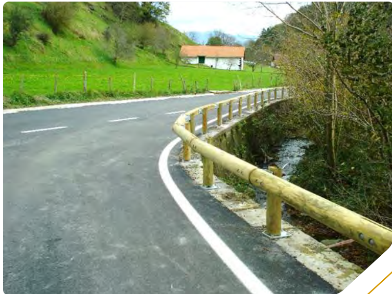
Route départementale – S42 sur longrine béton
