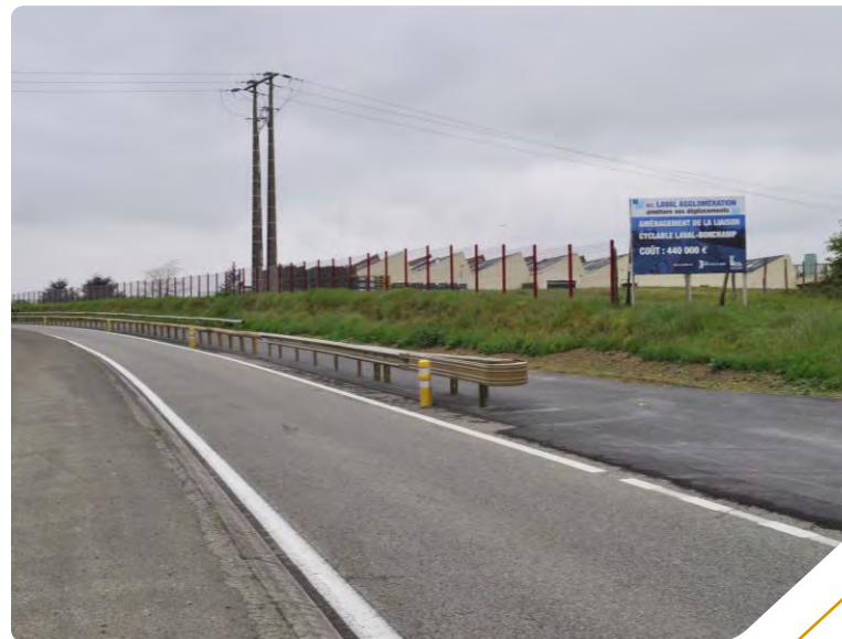
Extrémité de file performante raccordée sur glissière SOLOBOIS
